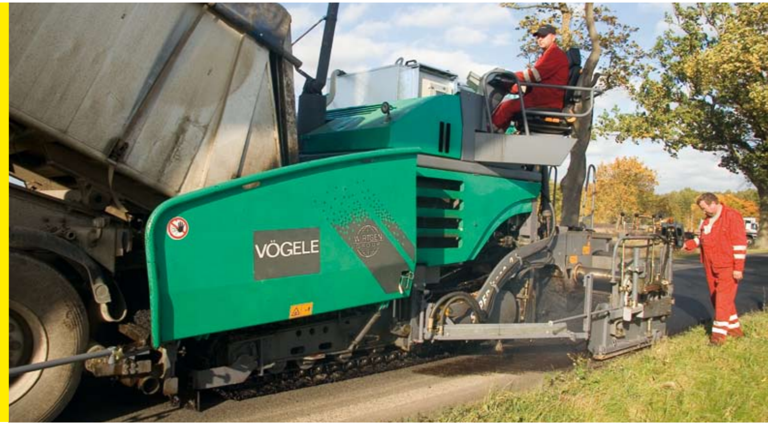
Las toberas pulverizadoras de alta calidad y con doble ranura (3 bar) son la garantía de un resultado excelente de riego.
